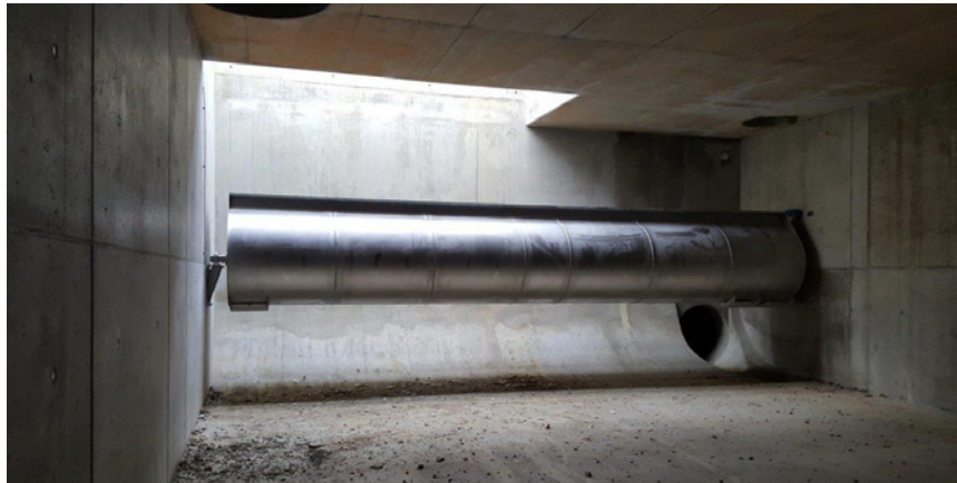
Bild 2: RÜB stecken voller Technik - FlowChief überwacht und steuert die Spülkippe zur Reinigung des Beckens
